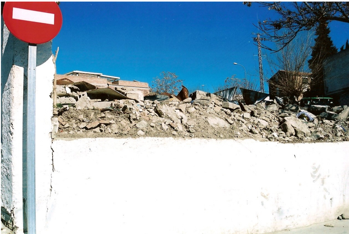
Solar de Don Jacinto donde se han abandonado escombros procedentes de derribos.
