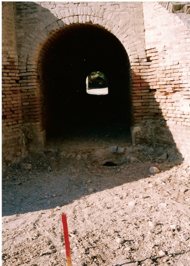
Salida peatonal al otro extremo de la vía a través de un túnel.
