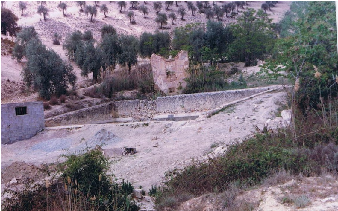
Instantánea de la alberca de aguas sulfurosas.
