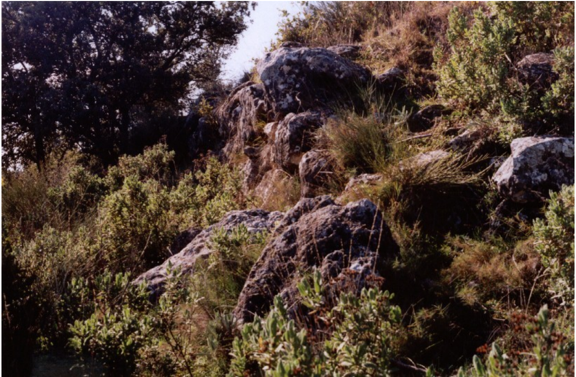
Distribución de la muralla vista desde el Sureste donde se observa una parte desmoronada.
