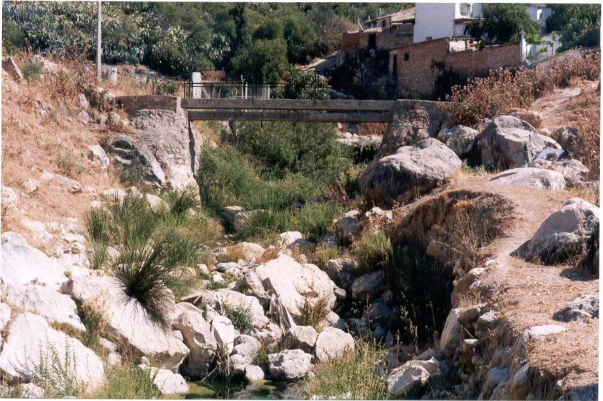
Instantánea del cauce del arroyo donde se observa al fondo las dos rocas hincadas sobre las que se ha construido el puente.
